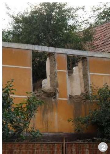
AȘA DA: Pereți din vălătuci (imagine din Gheorgheni)
