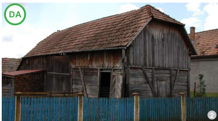
AȘA DA: Șopru cu structură de lemn în care s-au păstrat majoritatea elementelor originare.
