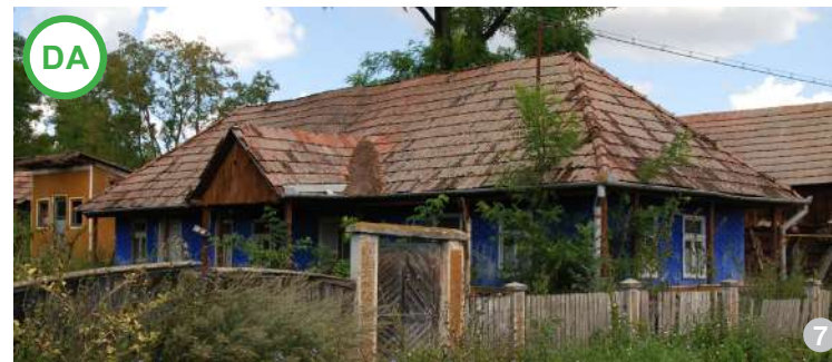
Acoperiș în patru ape cu foisor (imagine din Crăiești)
