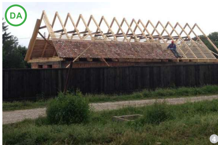
AȘA DA: Exemplul unei șarpante simple
