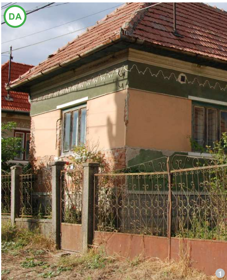
AȘA DA: Perete din cărămidă tradițională (imagine din Gheorgheni)
