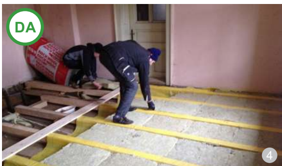
ASA DA: Izolarea podurilor și a pardoselilor cu materiale ecologice este recomandată. În imagine, detalii de compunere.
