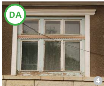
AȘA DA: Fereastră într-o singură foaie de geam (imagine din Bonțida)
