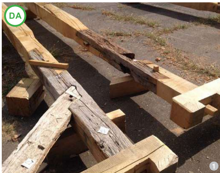
AȘA DA: Cadre tradiționale din lemn în timpul restaurării: un element afectat de degradare nu trebuie înlocuit cu totul.
