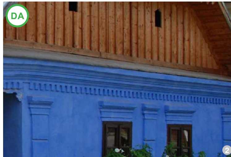
AȘA DA: Esențializarea unor forme ale arhitecturii vernaculare precum brăul din imagine poate fi de bun augur pentru tendința de încadrare în specificul local. Se recomandă ca acestea să nu fie confecționate din poliester, ci să se apeleze la o echipă de meșteri locali (imagine din Sic).
