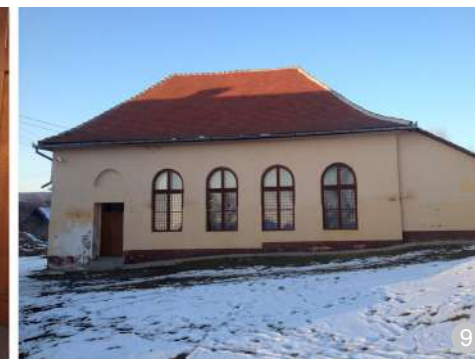
ASA NU: Reabilitarea unui cămin cultural prin izolarea cu polistiren. Folosirea polistirenului atrage după sine probleme legate de condens, igrasie, apariția mușegaiului și este un material ușor de vandalizat de către copii, animale, persoane agresive etc.
