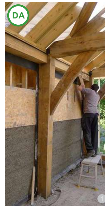
ASA DA: Pereți termoizolanți din Hempcrete
