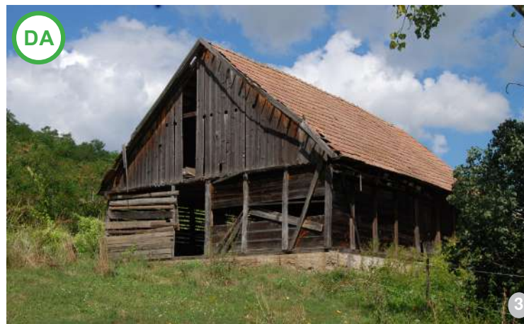
ASA DA: Exemplu de clădire cu gabarit mare care se integrează în peisaj prin materialele folosite pentru structură și spațiile de trecere, prin menținerea unei înălțimi moderate.
