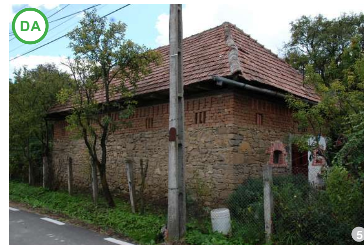
AȘA DA: Pereți masivi din piatră și cărămidă
