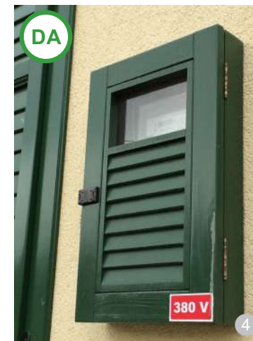
ASA DA: Mod de mascare și de protecție a unui contor electric
