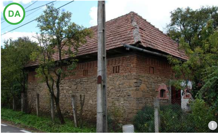
DA: Zid mixt din piatră, cărămidă și elemente din beton, care combină tehnica tradițională cu cea contemporană, pentru a corespunde cerințelor de stabilitate etc.
