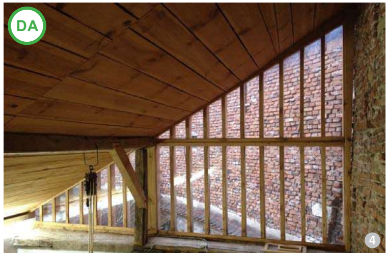
AȘA DA: Exemplul vitrării unui fronton, intervenție ingenioasă care este cu greu vizibilă din exterior, datorită lamelor late, care sugerează imaginea unui fronton din lemn.
