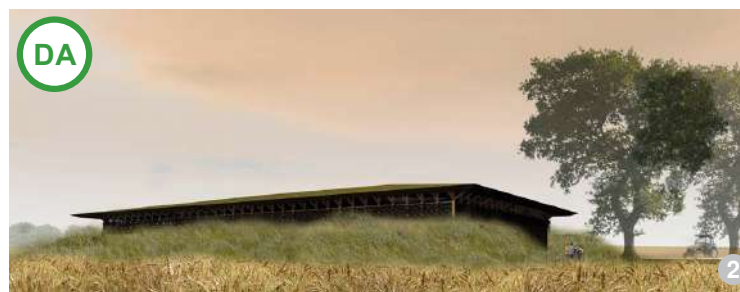
ASA DA: Acoperirea parțială și protejarea fațadelor de dimensiuni mari ale hălelor cu taluzuri de pământ acoperit cu vegetație, rezultat în urma escavărilor din timpul construirii obiectivului.
