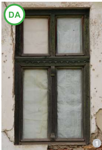
AȘA DA: Fereastră într-o singură foaie de geam (imagine din Bonțida)
