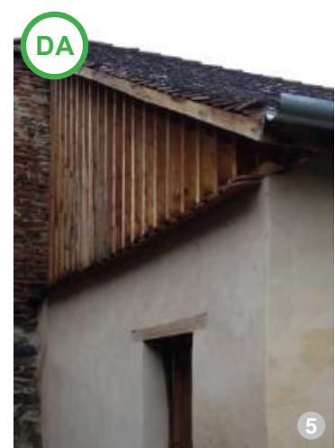
AȘA DA: Exemplul vitrării unui fronton, intervenție ingenioasă care este cu greu vizibilă din exterior, datorită lamelor late, care sugerează imaginea unui fronton din lemn.
