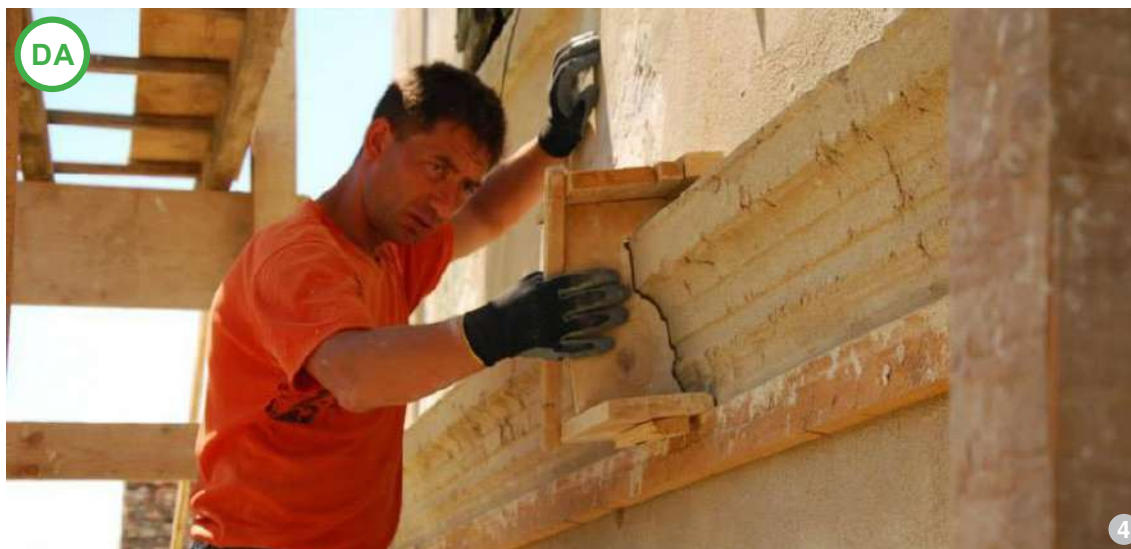
AȘA DA: Intervențiile la decorațiile de fațadă se vor face cu materiale și tehnici tradiționale: brâul din mortar de var va fi trăsut cu șablon de profil.
