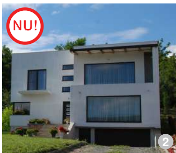
AȘA NU: Folosirea acoperirii generale de tip terasă este interzisă în satele tradiționale, motivul fiind neîncadrarea în specificul local atât prin formă, cât și prin aspectul învelitorii pe care o presupune utilizarea acestui tip de acoperire. Suplimentar, soluția de terasă poate aduce cu sine probleme de infiltrație a apei dacă nu este pusă în operă foarte bine, evenimentele multiple de acest gen confirmând afirmația noastră.
