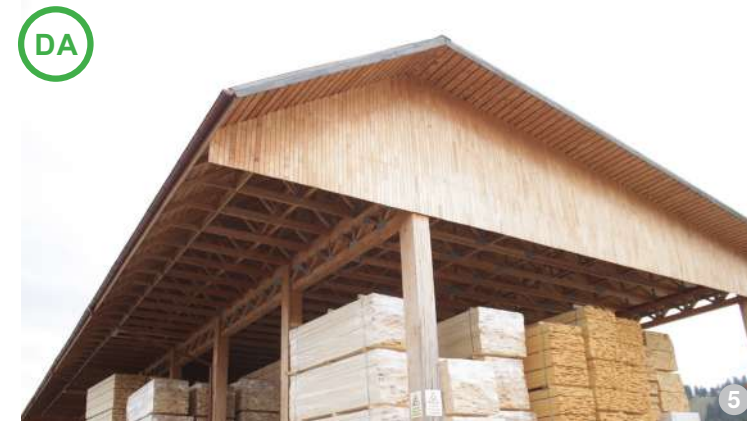
AȘA DA: Utilizarea unei structuri din lemn lamelar sau a unei structuri zăbrelele la nivelul șarpantei poate fi o soluție practică pentru clădiri cu deschideri mari.
