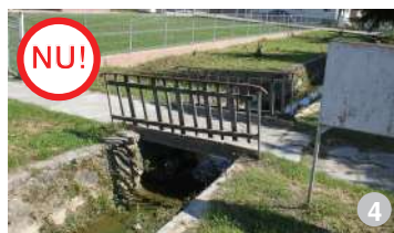
AȘA NU: Se vor evita podețele din beton și metal, materiale folosite în mediu urban.
