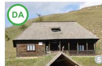
Acoperiș în patru ape, din șindrilă
