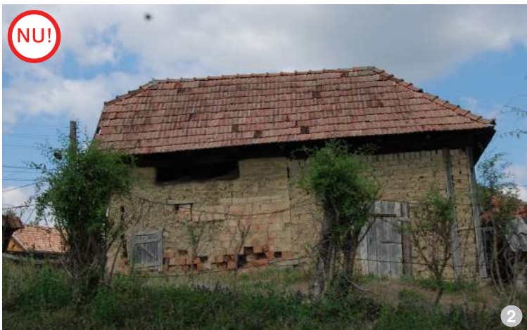
AȘA NU: Pentru repararea unui anumit tip de zidărie, se va folosi același material (în cazul de față, completarea zonelor deteriorate trebuia făcută cu vălătuci).
