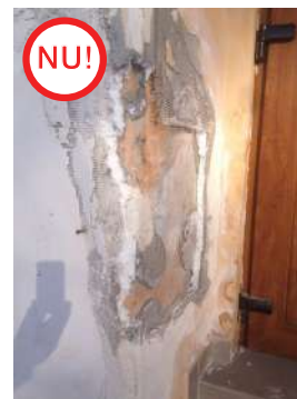
ASA NU: Reabilitarea unui cămin cultural prin izolarea cu polistiren. Folosirea polistirenului atrage după sine probleme legate de condens, igrasie, apariția mușegaiului și este un material ușor de vandalizat de către copii, animale, persoane agresive etc.
