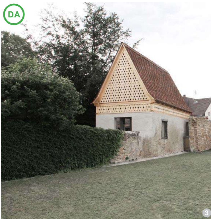
ASA DA: Intervenție de reconstruire a unui acoperiș și de înălțare a construcției. Intervenția contemporană este vizibilă prin folosirea unui model de traforaj aparte, dar forma tradițională a acoperișului este respectată.
