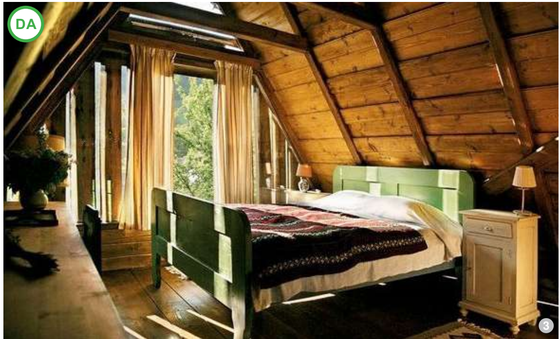
AȘA DA: La construcțiile anexe în care se amenajează spații de locuit mansardate, se pot utiliza procedee precum cel din imagine, privind vitrarea întregului fronton, mai ales dacă acesta a fost inițial din lemn.
