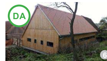
AȘA DA: Pentru construcții cu funcțiuni industriale, cu deschideri mari, se pot folosi sisteme structurale combinate, atât metalul, cât și lemnul, pentru a permite utilizarea unor materiale locale pentru finisaje și învelitori precum țigla și lambriul (imaginea de sus: interior; imaginea de jos: exterior).
