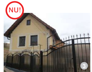
AȘA NU: Nu se recomandă folosirea împrejmuirilor din PVC și fier forjat în stil „rustic”. Aceste materiale degradează imaginea așezărilor.
