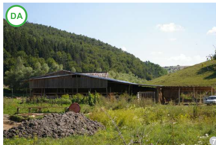
AȘA DA: Pentru camuflarea gabaritelor mari și în cazul în care se dorește acest lucru, se pot folosi acoperișurile verzi cu înclinație mică. Se observă intenția de camuflare prin crearea unui brâu de pământ în jurul construcției, rezultat parțial din săpătura necesară construirii edificiului. Aceste procedee se pretează la clădiri de dimensiuni foarte mari, precum săli de sport, hale de producție, spații de depozitare a cerealelor etc.
