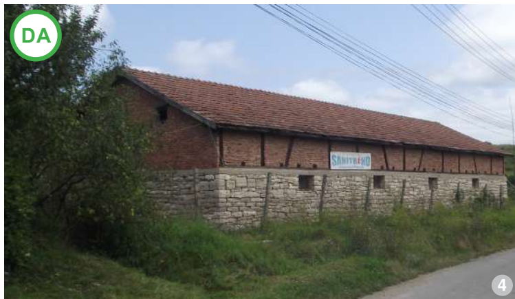
AȘA DA: Exemplu pentru volumetrie simplă, în care panta acoperișului se apropie de valoarea celei adecvate.
