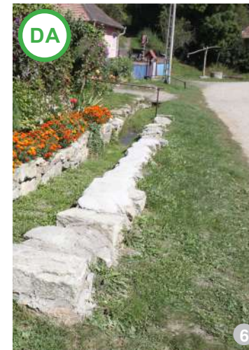
AȘA DA: Amenajarea cu piatră a rigolei de scurgere a apelor pluviale
