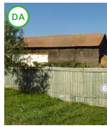
AȘA DA: Perete de împletitură pe verticală (imagine din Pănet)
