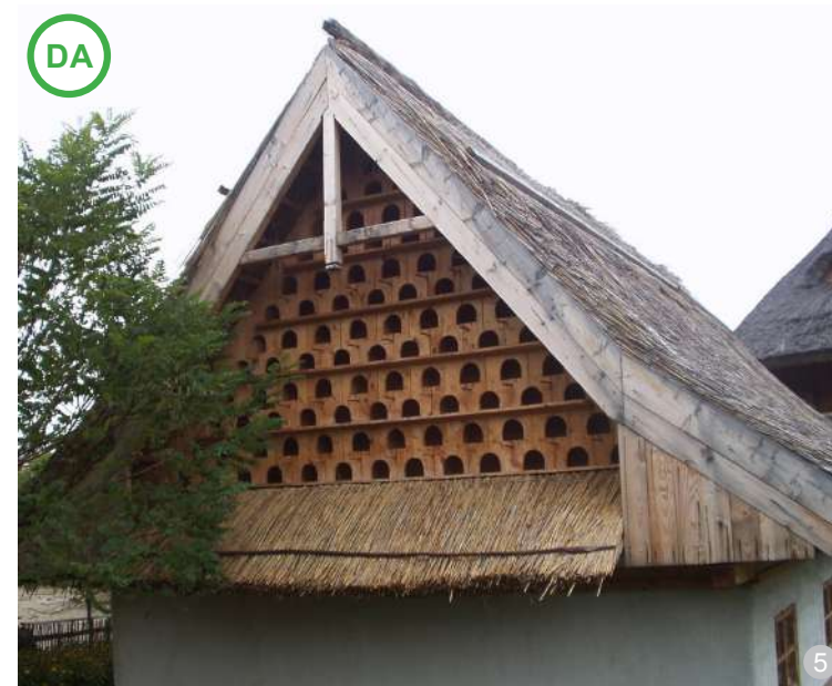
ASA DA: Decorarea frontonului acoperișului nou cu un trafor destinat accesului pormbeilor este un element atât decorativ, cât și funcțional.
