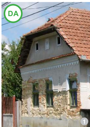
AȘA DA: Pereți din cărămidă (imagine din Sic)
