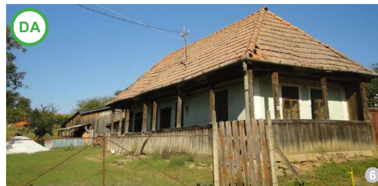
Acoperiș în patru ape (imagine din Pănet)
