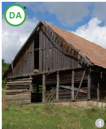
AȘA DA: Exemplu pentru volumetrie simplă, în care panta acoperișului se apropie de valoarea celei adecvate.
