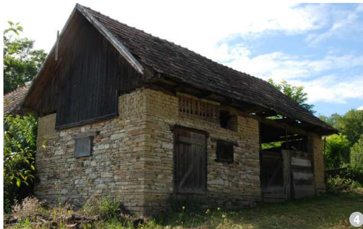
AȘA DA: Zidăriile din piatră se recomandă a fi lăsate aparente, imaginea lor contribuind în mod favorabil la peisajul satului (imagine din Vaida-Cămăraș).
