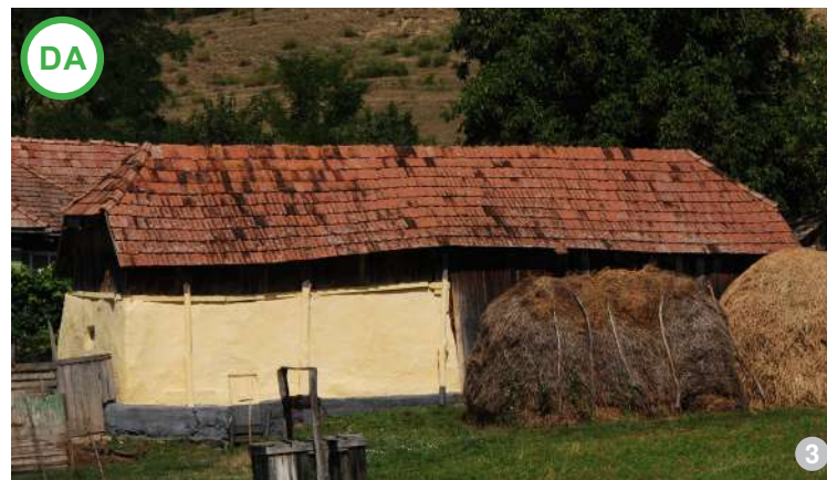
AȘA DA: Perete de împletitură în cadre cu lipitură
