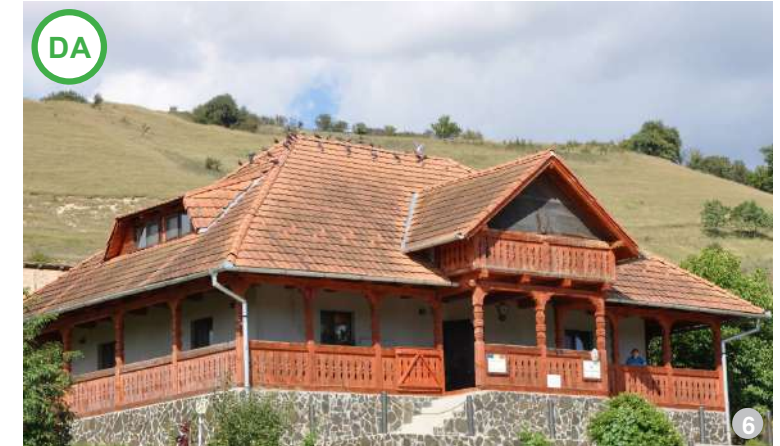
AȘA DA: Țigla trasă industrială, de formă și cu dispunere specific locală, poate constitui o variantă pentru acoperirea construcțiilor noi de gabarit mare.
