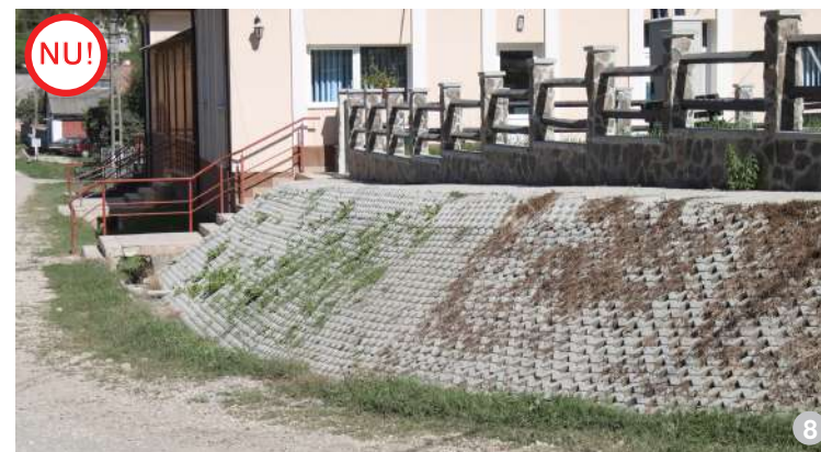
AȘA NU: Se va evita amenajarea taluzurilor și a malurilor pâraurilor cu pavele de beton
