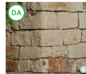
AȘA DA: Zidărie din piatră nerostuită, prelucrată manual
