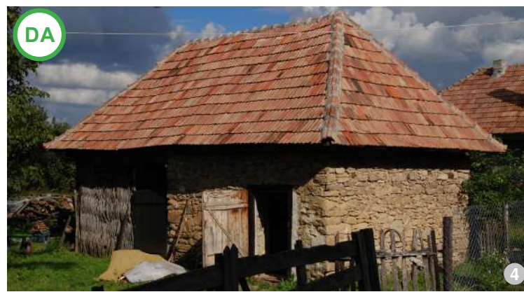
AȘA DA: Perete de împletitură pe verticală (imagine din Gheorgheni)
