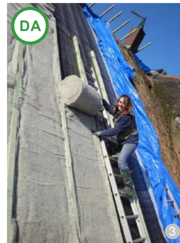
ASA DA: Termoizolația din lână este deosebit de recomandată. Folosirea unei izolații din lână sprijină o industrie a prelucrării produselor locale: în mod frecvent, lâna se aruncă, în loc să fie utilizată. Această măsură este încă la început în țara noastră, dar se folosește cu succes și pe scară largă în majoritatea țărilor europene.
