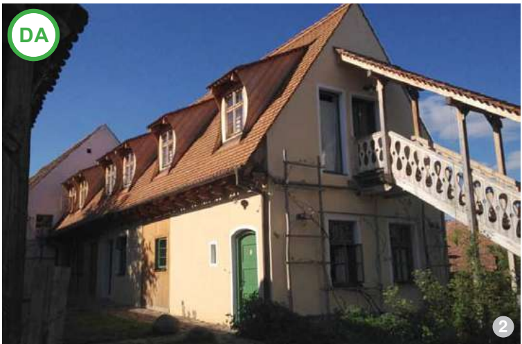
AȘA DA: Amenajarea unor goluri în frontonul din spate poate fi o soluție care nu modifică volumetria clădirii. Se recomandă atenție la posibila existență a unor inscripții sau decorații valoroase; în acest caz, nu se recomandă decuparea golului.
