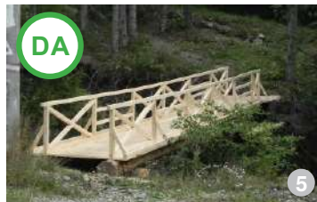
AȘA DA: Exemplu de podeț nou de lemn
